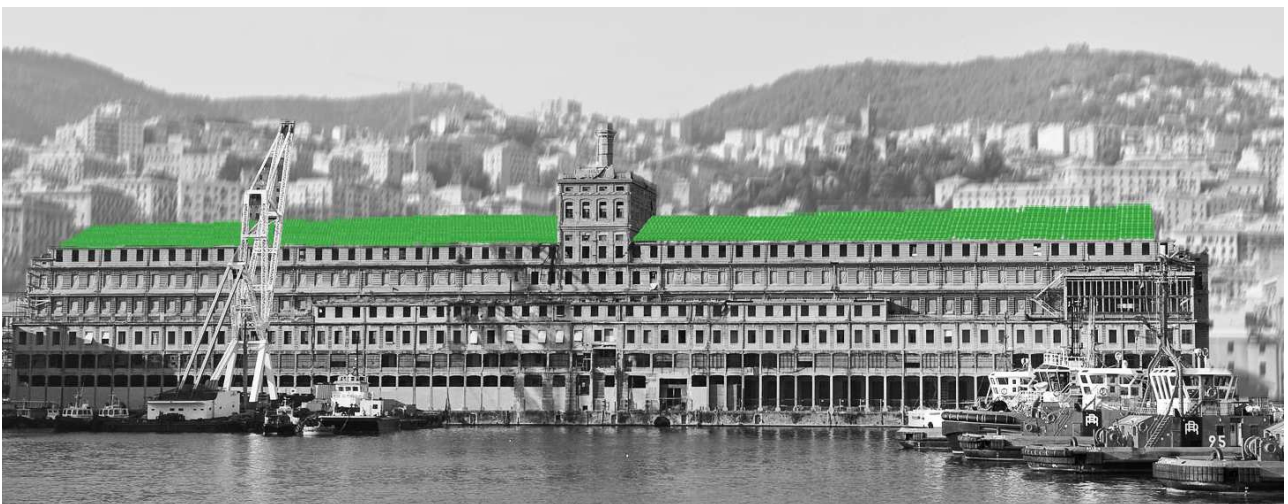
Fig. 1 Hennebique con pannelli fotovoltaici
